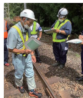
写真2 弱点箇所の現地視察及び診断
