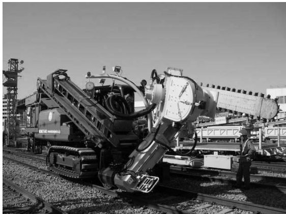
もも太郎 (道床掘削機)
