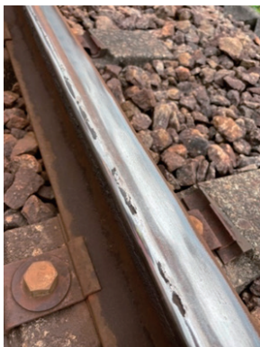
図9 軌間の遊びによるレール損傷
