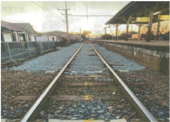
写真② 【No. 1】 道床交換後の駅構内
