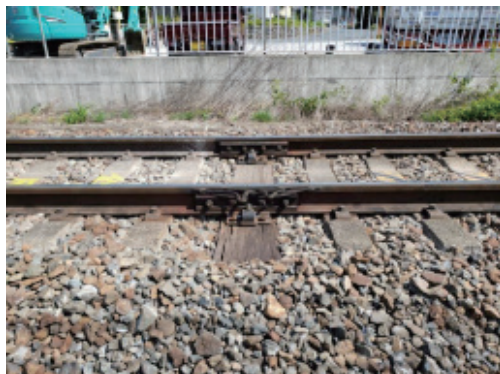
写真③ 【No. 7】 継目部の騒音
