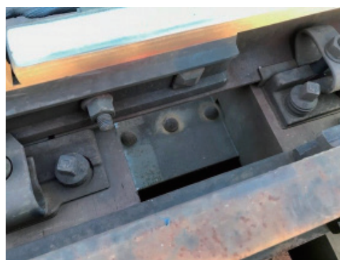
写真6 【No.5】 アンカーボルトの折損
