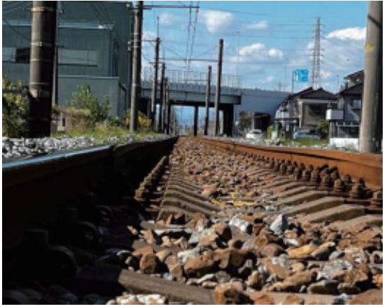
写真③ 【No. 2】 高く見える伸縮継目部
