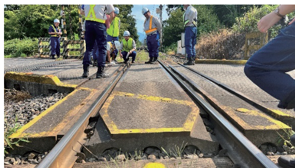
写真7 【No.6】 接続ブロックの沈下
