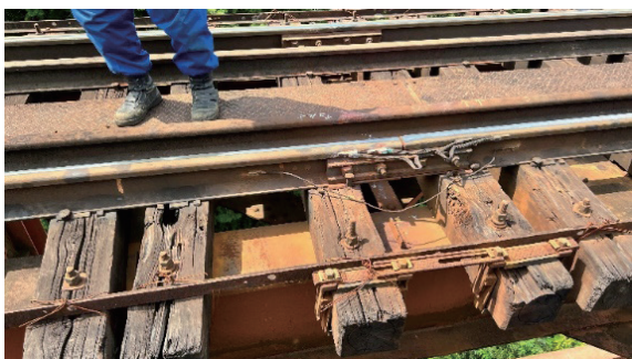
写真5 【No.4】 橋梁部の継目ボルト折損等
