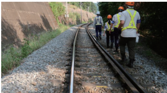
写真4 【No.3】 曲線部の通り不良
