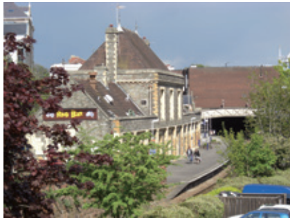
写真⑩ クリフトン・ダウン駅の駅舎をセント・ジョンズ・ロードの跨線橋から望む。駅舎の一部はパブとなっている。
