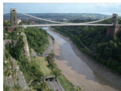
写真⑨ 1864年に完成したクリフトン吊橋をエイヴオン川の下流方から望む。右の崖下にはブリストル・アンド・ポーティスヘッド・ピア・アンド鉄道の線路が見える。
