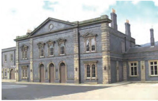
写真② フォウラーの設計によるウルヴァハムプトン・ロー・レベル駅の正面。青レンガと黄褐色の切石の縁取りが美しい駅舎は、両側に長い直線状のウィングが連なっている。
