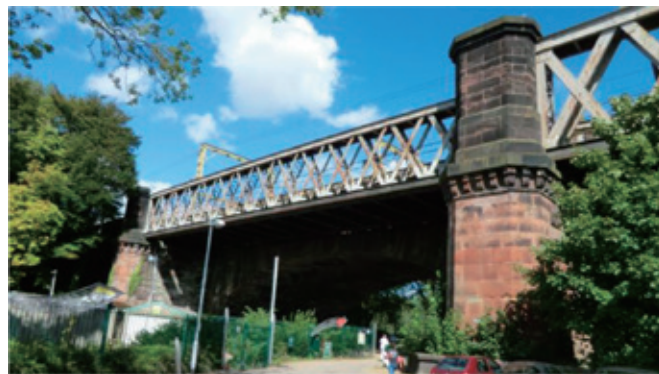
写真③ プレストン・アンド・ウィガン鉄道が建設したリブル河を横断する橋梁。開業時の橋梁は石造アーチ橋 (向こう側)。後に複々線化工事でラチス・トラス橋 (手前側) が建設された。上流方を望む。
