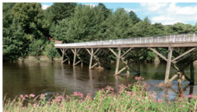
写真② リブル河を横断するオールド・トラムロードの木造橋梁 (橋脚は鉄筋コンクリート造で再現された)。左がプレストン方。
