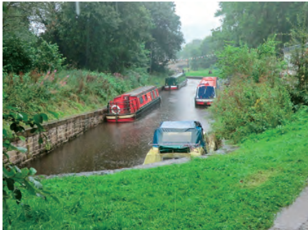
写真③ エルズミア運河のスランタシリオ運河支線のベイズン。ここにルーアボン・ブルック・トラムウェイの水陸連絡設備が建設された。
