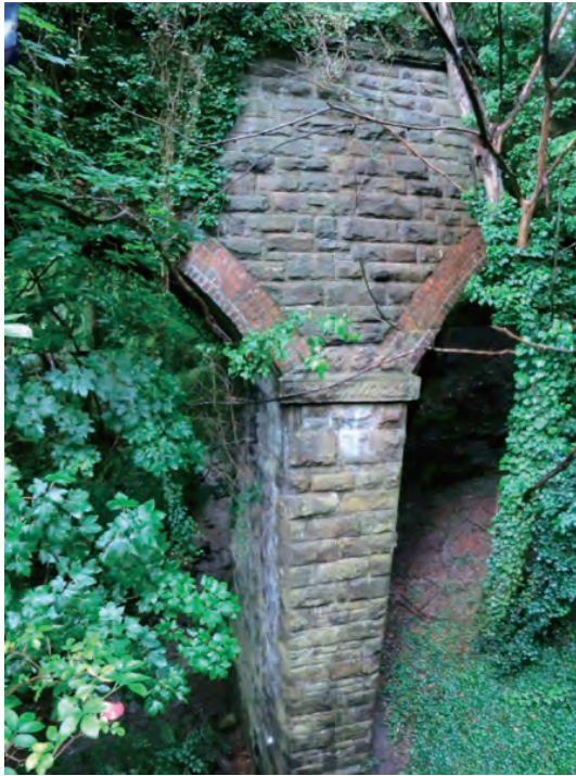
写真⑤ エイカーバイル・ブルックの小河川を横断するために建設された石積高架橋。
