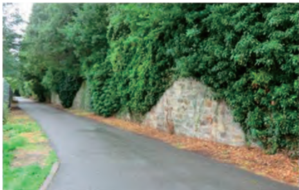
写真④ ニューブリッジ・ロード (Newbridge Road) 沿いの切土 (一部石造土留壁) の上をルーアボン・ブルック・トラムウェイが走った。左手奥はポイントカサルテ・ベイズン。
