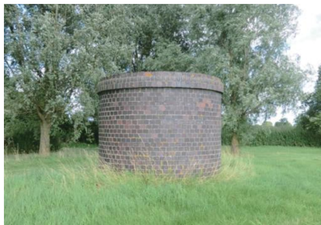
写真4 バターミルク・ホール・ファームの農家の庭にある2基の立坑の一つ。この立坑は現在のブリスワース運河トンネルの軸線上にはない。
