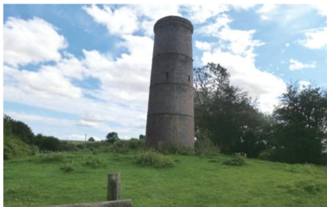
写真② トンネル・ヒル・コテージズの傍らにある立坑。ブリスワース・ヒル鉄道は写真の左方を走行した。
