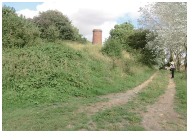
写真3 バターミルク・ホール・ファームの農家の庭にある2基の立坑の一つ。周囲はズリが堆く盛られている。
