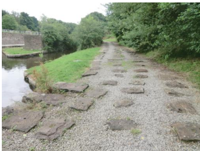
写真⑥ バックスワース・ベイズンの北端に残るピーク・フォーレスト・トラムウェイの石の枕木。
