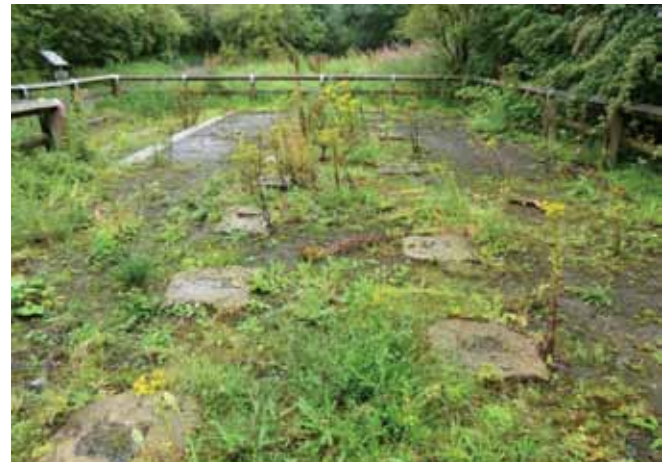
写真⑦ ウォールズエンド・バーンの北側に残るキリングワース・ワゴンウェイの石ブロックの枕木の跡。
