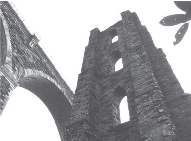
写真-4 ムアズウォーター高架橋を見上げる。手前(下り線側)の橋脚は木造高架橋を支持した石造橋脚の跡。石造橋脚には4段のゴシック・アーチが割り貫かれている。
