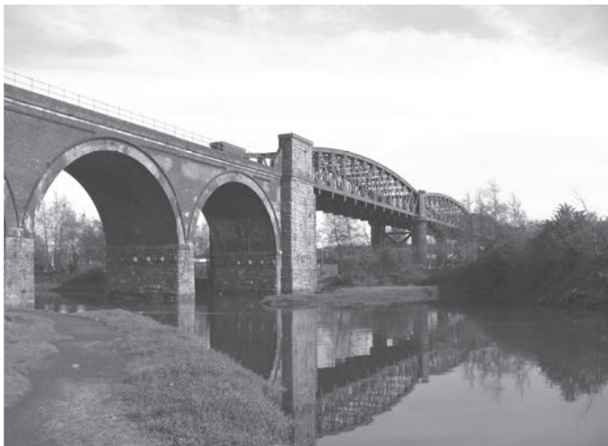
写真-2 ウェストン・ミル高架橋のプリムス方を見る。木造橋梁は、左(上り線)方にあった。
