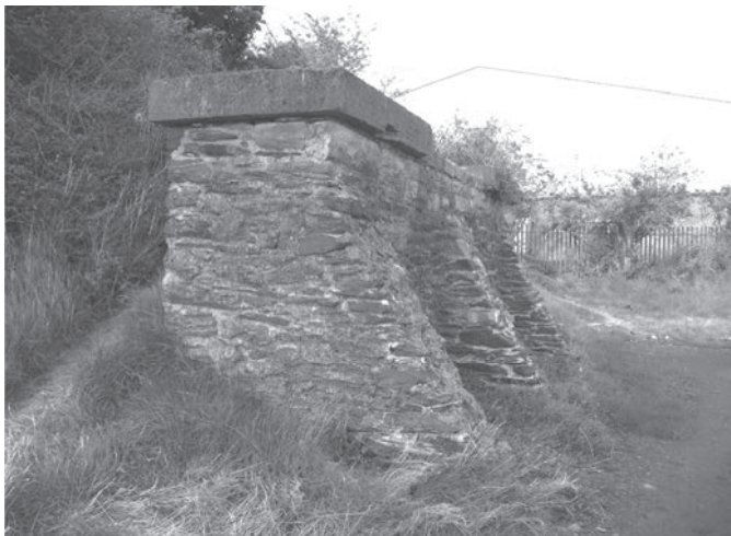
写真-1 ウェストン・ミル高架橋の木造橋脚の跡。手前に現在の橋梁がある。
