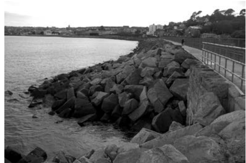
写真-4 ペンザンス木造高架橋は、防潮堤を兼ねた盛土に変更された。向こうはペンザンス駅。
