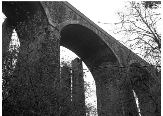
写真-1 アイヴィブリッジ高架橋。手前は現在線の石造アーチ橋。向こうに木造橋梁を支持した石造橋脚が見える。
