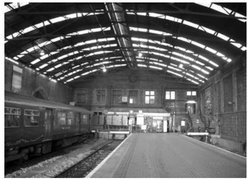
写真-3 イギリス最西端の終着駅ペンザンス駅は開業当時とほとんど変わっていない。
